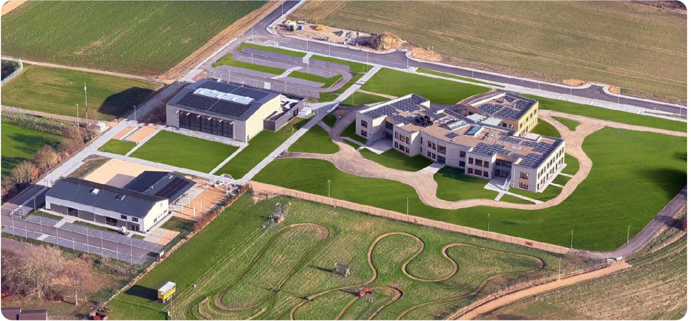
Die neue soziale Mitte des Doppeldorfs aus der Luft – alle drei Neubauten sind mit Lüftungstechnik von Airflow ausgestattet.
