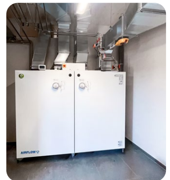
Links: Viel Tageslicht durch Glasfront und Oberlicht: Die Zweifeld-Sporthalle bietet Raum für bis zu 60 Sportlerinnen und Sportler oder zwei Schulklassen. Rechts: Bedarfsgerecht geregelt: Ein Lüftungsgerät DUPLEXbase PT 1800 lüftet Umkleiden und Duschräume und reagiert dort über Feuchtesensoren.
