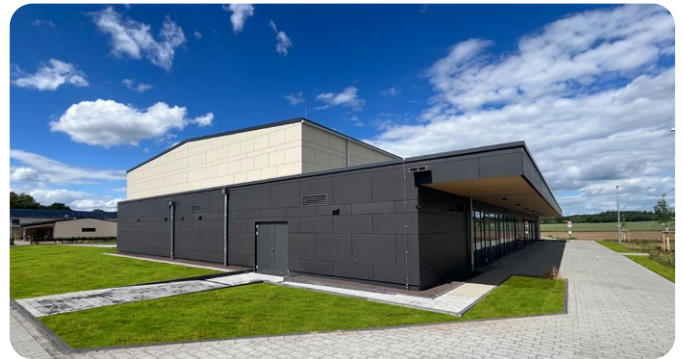
Vormittags Schule, nachmittags Vereine: die neue Zweifeld-Sporthalle in Holzfachwerkbinderkonstruktion.
