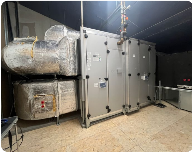
Millimeterarbeit beim Einbau: Das DUPLEX Roto 15000 wurde fertig montiert in die beengte Technikzentrale im Obergeschoss eingebracht, bevor die Gebäudehülle geschlossen war.
