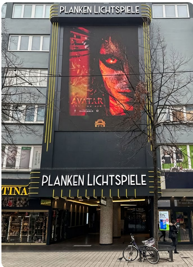
Die Planken Lichtspiele Mannheim wurden umfassend modernisiert und mit hocheffizienten Lüftungsgeräten von Airflow ausgestattet.
