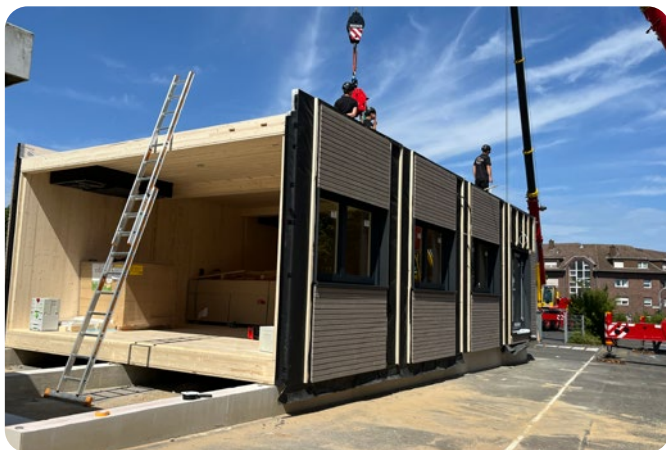
Die fertigen Module wurden mithilfe von Lastwagen und Kränen an ihren finalen Standort transportiert.
