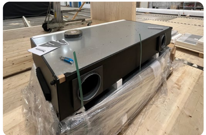
Der Einbau der DUPLEX Vent X Lüftungsgeräte erfolgte in der Produktionshalle im Rahmen der werkseitigen Vorfertigung der Module.
