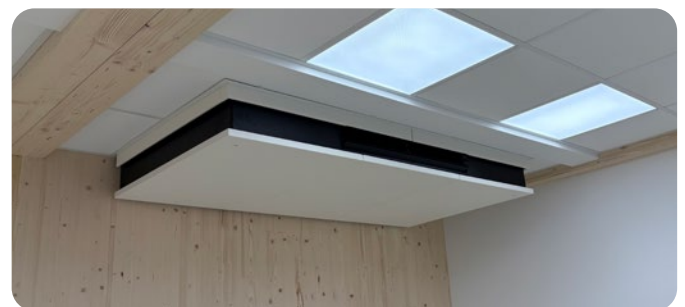
Das DUPLEX Vent X stellt als erstes dezentrales Lüftungsgerät mit integrierter Wärmepumpe eine vollständige All-in-One-Lösung für die Bereiche Lüften, Heizen und Kühlen dar.
