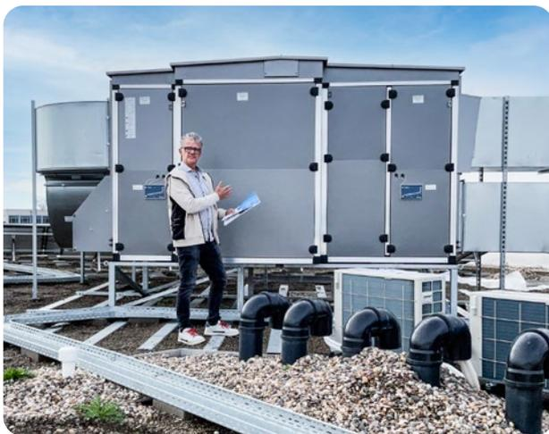
Udo Rausch, Vertriebsbeauftragter Lüftungsgeräte bei Airflow, begleitet die Planung der Lüftungstechnik von Beginn an. „Eines unserer größten zentralen Lüftungsgeräte, das DUPLEX 9000 Multi Eco-N, wurde auf dem Dach installiert und versorgt größere Nebenbereiche und Flure der Schule.“
