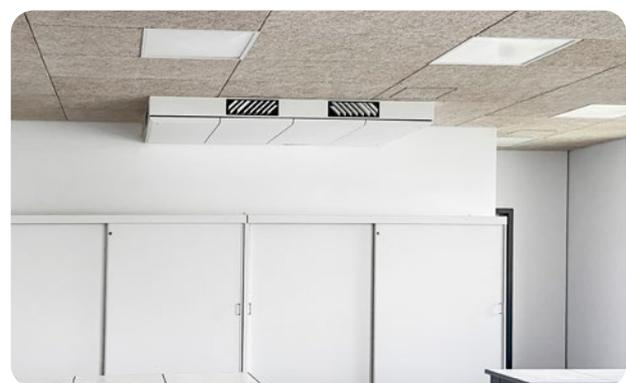
Schluss mit ineffizientem Fensterlüften: In den 49 Klassen- und Fachräumen der neuen Schule sorgen die zentralen Airflow Lüftungsgeräte DUPLEX Vent S 1000 für eine konstante und energiesparende Frischluftzufuhr.
