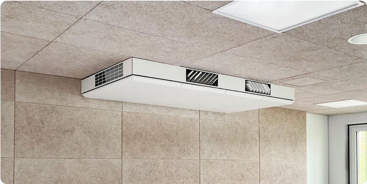
Die zentralen Airflow Lüftungsgeräte wurden deckenmontiert und sind somit besonders platzsparend und optisch unauffällig. Mit ihrem niedrigen Schallpegel und aktiver Geräuschunterdrückung mittels ANC-Technologie schränken sie selbst im Vollbetrieb die Konzentrationsfähigkeit der Schüler nicht ein.
