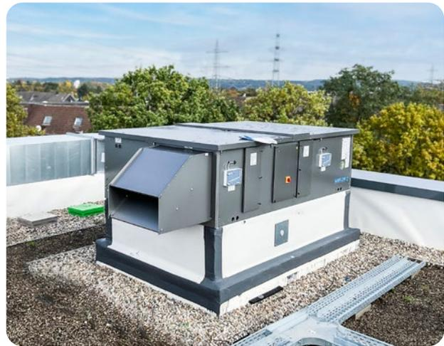
Das zentrale Lüftungsgerät DUPLEX 2500 Multi Eco-N ist ebenfalls für die Versorgung von Nebenbereichen im Schulneubau zuständig. Alle Multi Eco Geräte verfügen über einen hocheffizienten Kreuzgegenstrom-Wärmetauscher und erzielen einen Wärmerückgewinnungsgrad von bis zu 93 Prozent.
