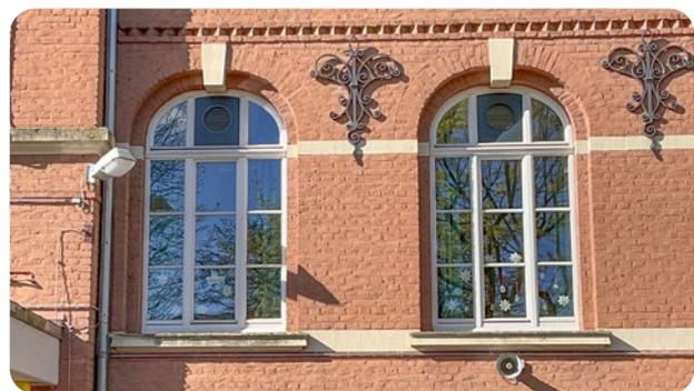
Von außen quasi unsichtbar: Die Zugänge für Außen- und Fortluft integrieren sich perfekt in die Fassade. (Bild: Airflow)
