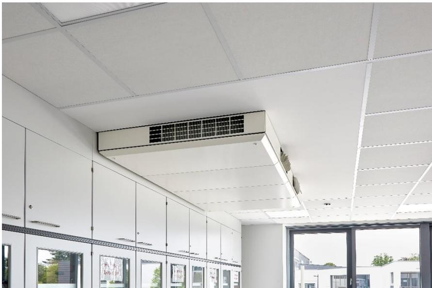
Leicht zu montieren: Die dezentralen DUPLEX Vent Geräte lassen sich flexibel komplett oder teilweise in die Decke integrieren.
