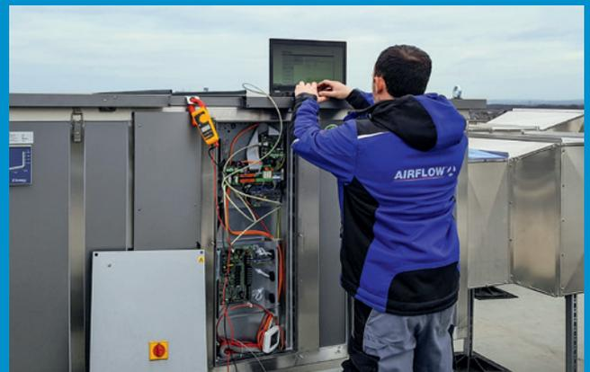
Die genaue Prüfung des dynamischen Betriebsverhaltens sowie der Funktion von Regelgeräten und -kreisen gehören selbstverständlich zu unserem Service.
