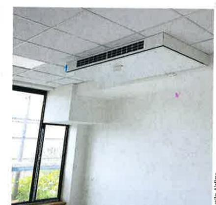
Durch die dezentrale Einbauweise wird jeder Raum ganz individuell mit frischer Luft versorgt. Das Lüftungsgerät wurde hier als Deckenmodell zu 2/3 teiltintegriert in die Zwischendecke eingebaut.
