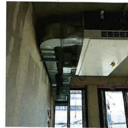
Die Airflow Lüftungsgeräte der Duplex Vent-Serie wurden an den Decken der jeweiligen Räumlichkeiten angebracht. Dabei musste darauf geachtet werden, dass die Montage nahe der Außenwand erfolgte.
