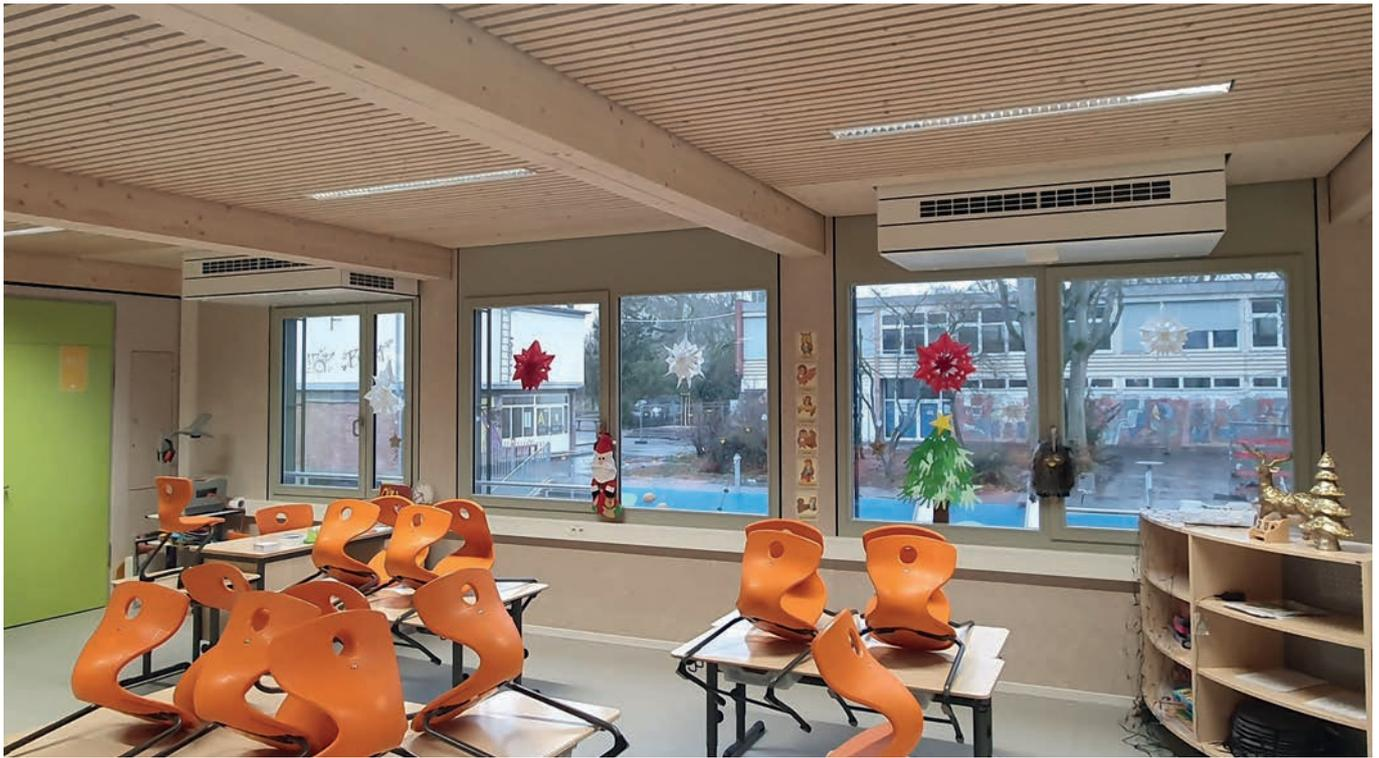
! Durch die dezentrale Einbauweise wird jeder Klassenraum ganz individuell mit frischer Luft versorgt.
