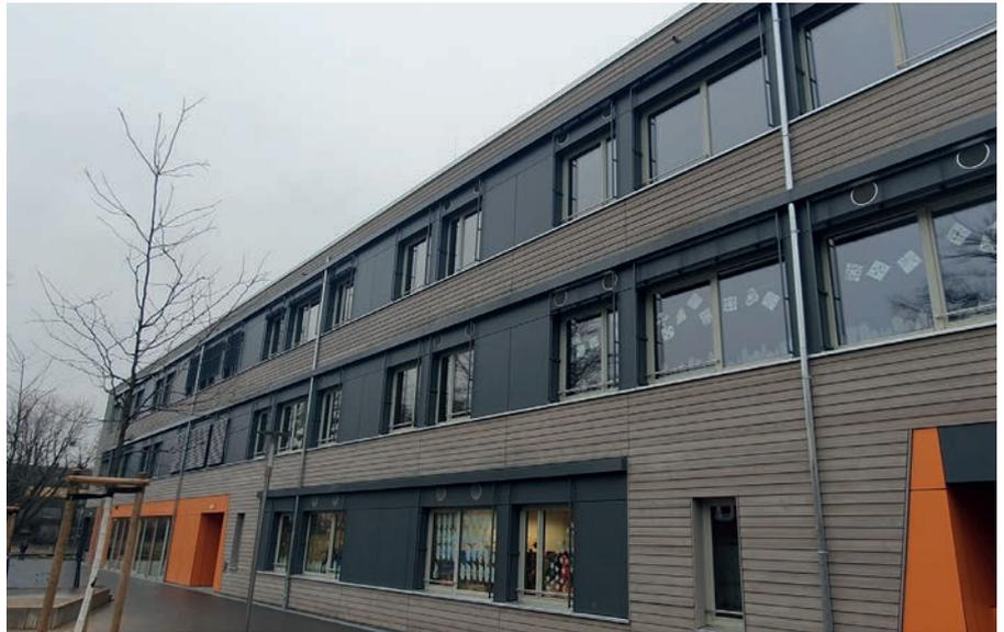
Der Neubau der Ursula-Wölfel-Grundschule in Wiesbaden setzt sich komplett aus vorgefertigten Holzmodulen zusammen. Für eine frische Lernatmosphäre für die 220 Schüler und ihre Lehrer sorgt ein ausgeklügeltes System aus dezentraler und zentraler Lüftungstechnik der Firma Airflow Lüftungstechnik GmbH aus Rheinbach.
