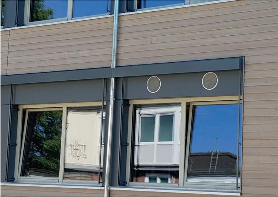
**I** Montage in Rekordzeit: Dank präziser Vorarbeit in den Außenwänden mussten die Lüftungsgeräte vor Ort nur noch mit dem Außen/Fortluftluftdurchlass verbunden werden.
