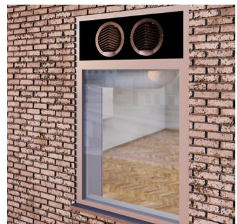
Außenansicht des Fensters mit zwei Fassadengittern für die Befestigung zur Ausleitung der flexiblen Rohre.
