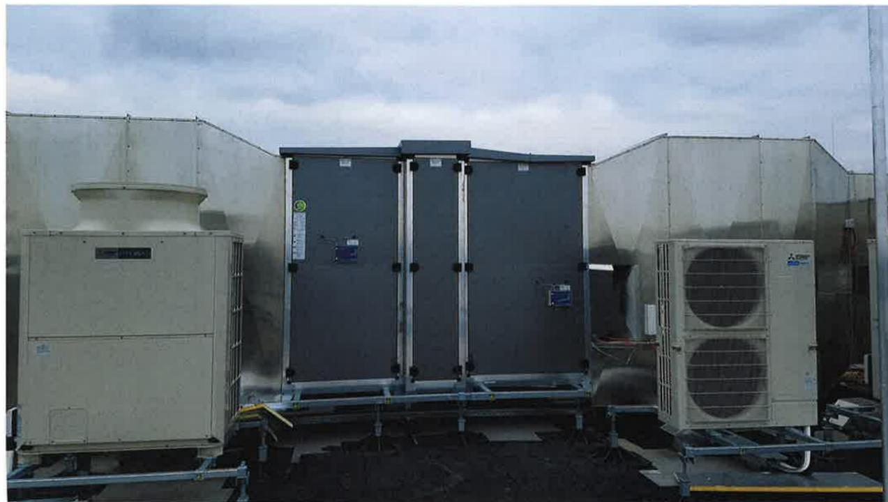
! Fertig installiert und bereit zur Inbetriebnahme: das zentrale Airflow Lüftungsgerät DUPLEX 12000 Roto N mit Rotationswärmetauscher.
