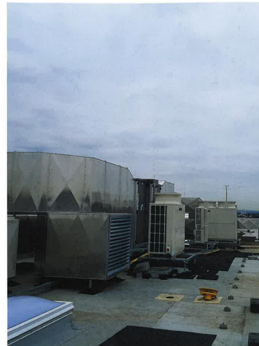
! Dank des vergleichsweise geringen Gewichts von 600 bzw. 640 kg sind die Airflow Geräte ideal für eine Dachinstallation.
