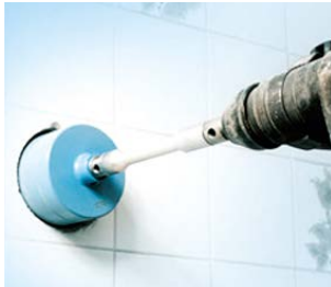
Kernbohrung in der Wand
