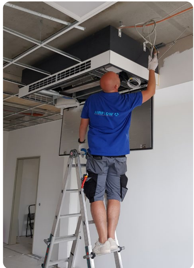
Die Airflow Lüftungsgeräte der DUPLEX Vent Serie wurden an den Decken der jeweiligen Räumlichkeiten angebracht. Dabei musste darauf geachtet werden, dass die Montage nahe der Außenwand erfolgte.
