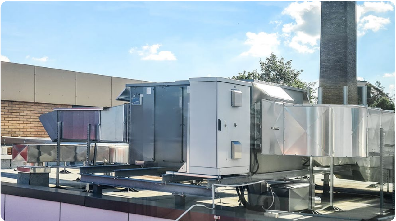
Die zentralen Lüftungsgeräte der Serie DUPLEX Multi Eco-N sind auf dem Dach montiert. Sie versorgen die innenliegenden Sanitär-, Lager- und Technikräume sowie die Sporthalle.
