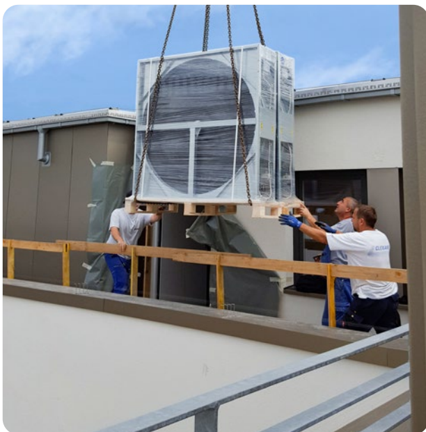
Komplizierter Transport: Mit vereinten Kräften haben die Installateure die Geräte durch einen Hintereingang im obersten Stock zur Lüftungsanlage unter dem Dach geschafft.
