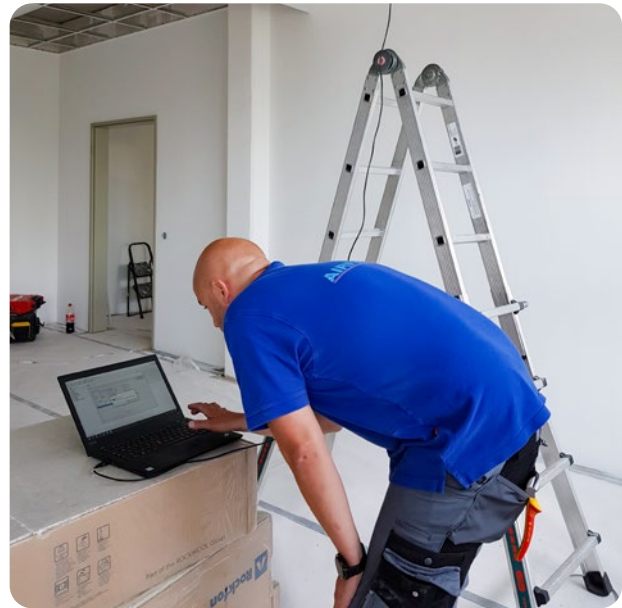
Inbetriebnahme eines Lüftungsgerätes durch einen Airflow Servicetechniker.
