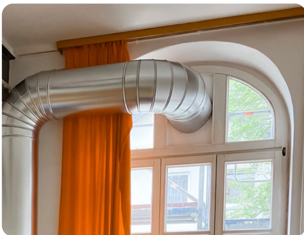
Die Herausforderung: Das historische Schulgebäude aus dem Jahr 1894 steht unter Denkmalschutz. Bei der Installation der neuen Lüftungstechnik musste die traditionelle Backsteinfassade daher unbedingt erhalten werden. Aus diesem Grund wählte man das Fenster als Durchgang für Außen- und Fortluft. (Bild: Gebäudemanagement der Stadt Aachen)
