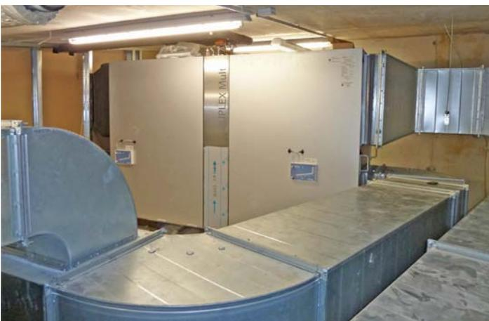
Das Lüftungsgerät für das EG wurde in einem Zwischenraum zwischen den Etagen verbaut.
