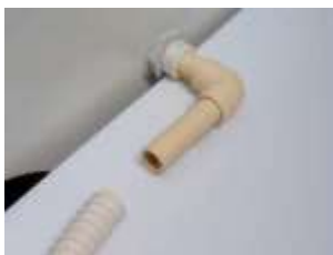
Anschluss des Kondensatablaufs durch den 90°-Bogen Vorbereitung für die Befestigung des Schlauchs
