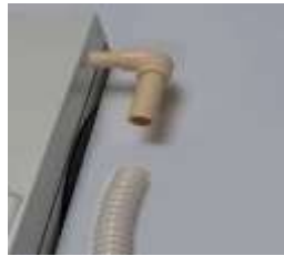
Anschluss des Kondensatablaufs durch das 90°-Kniestück – für die Befestigung des Schlauchs
