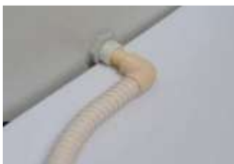
Befestigung des Schlauchs, mit einer Schelle sichern (Schelle ist Lieferumfang der Montagefirma)
