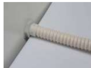
Befestigung des Schlauchs, mit einer Schelle sichern. (Schelle ist Lieferumfang der Montagefirma)
