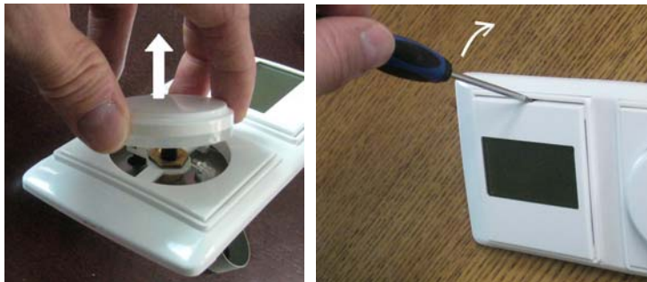
Bild 10 Demontage des Schutzdeckels
